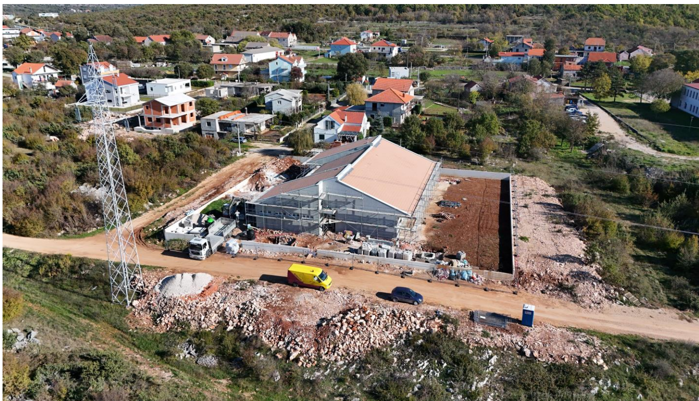
Građenje dječjeg vrtića u Dicmu
