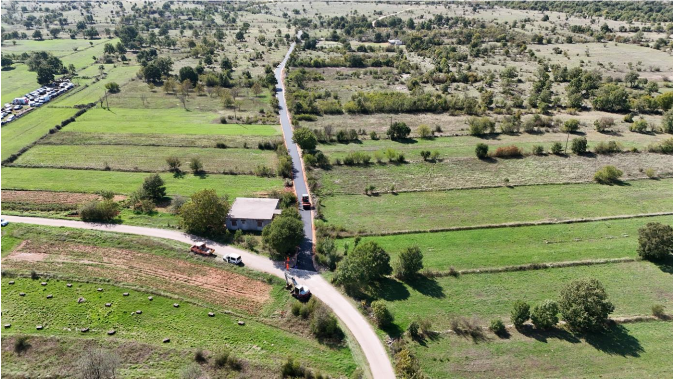
Asfaltiranje prvog dijela ceste kroz polje, spoj Krušvara i Ercegovaca
