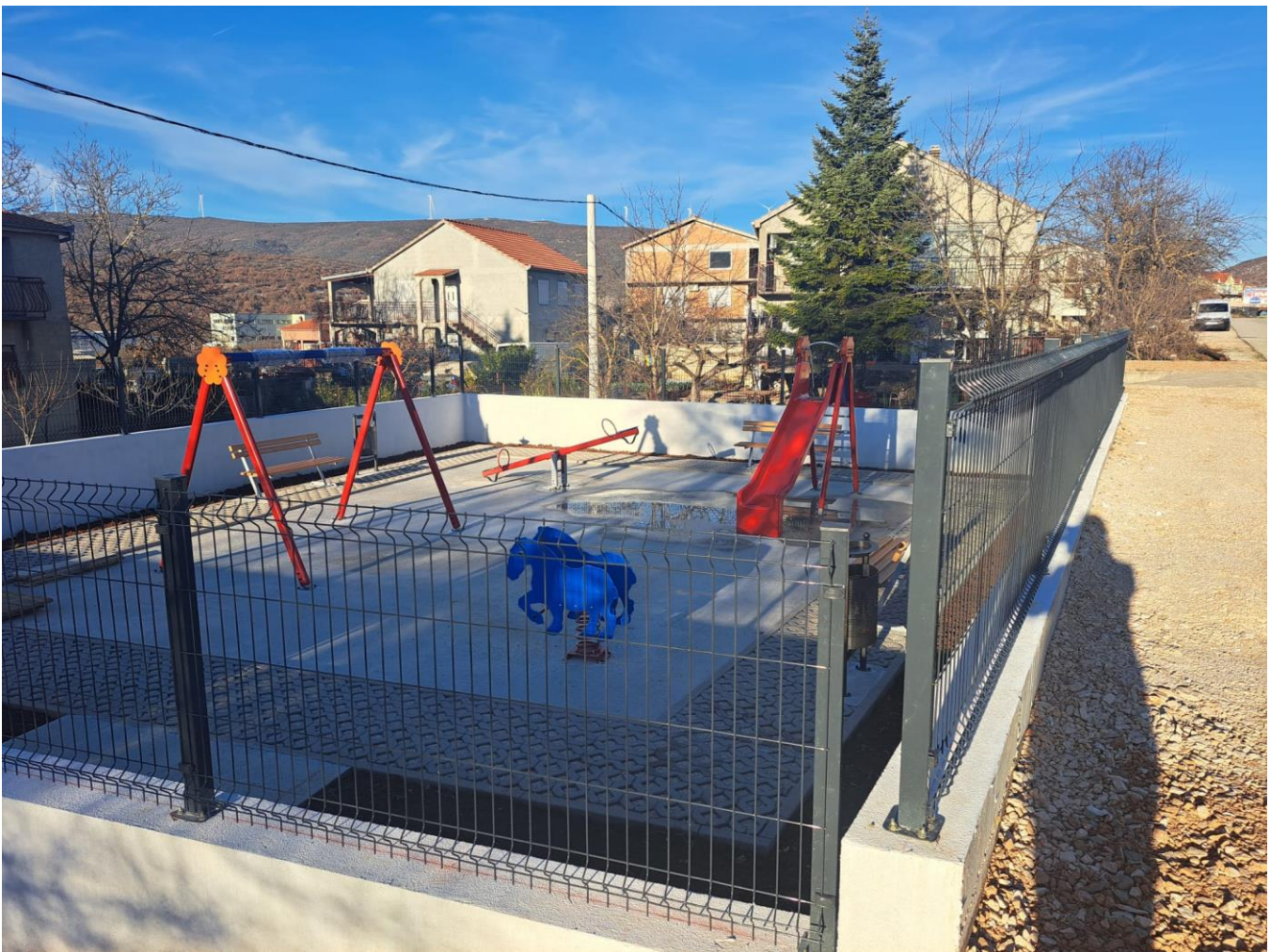
Izgradnja dječjeg igrališta u Kraju
